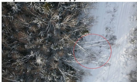
Рис.3. Обрушение на линии
