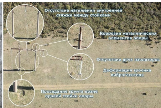
Рис. 4. Обследование ВЛ с беспилотника «Птеро»
