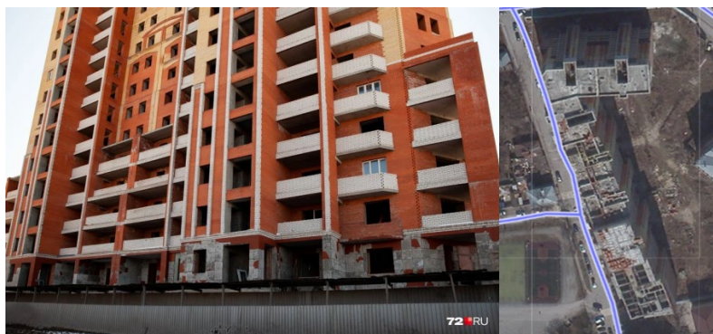
Рис. 4. Недострой жилого здания на ул. Герцена – Камышинской
