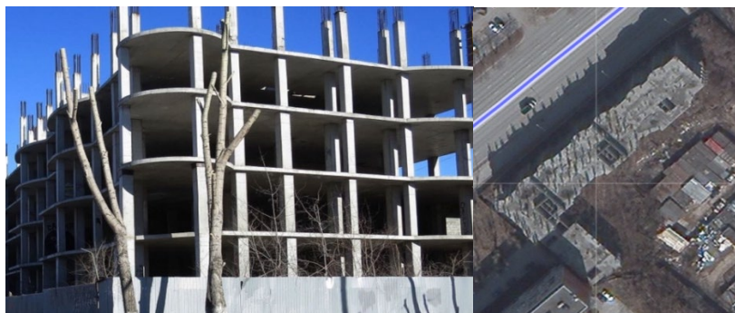
Рис. 2. Недострой на ул. Мельникайте 65 здания института
