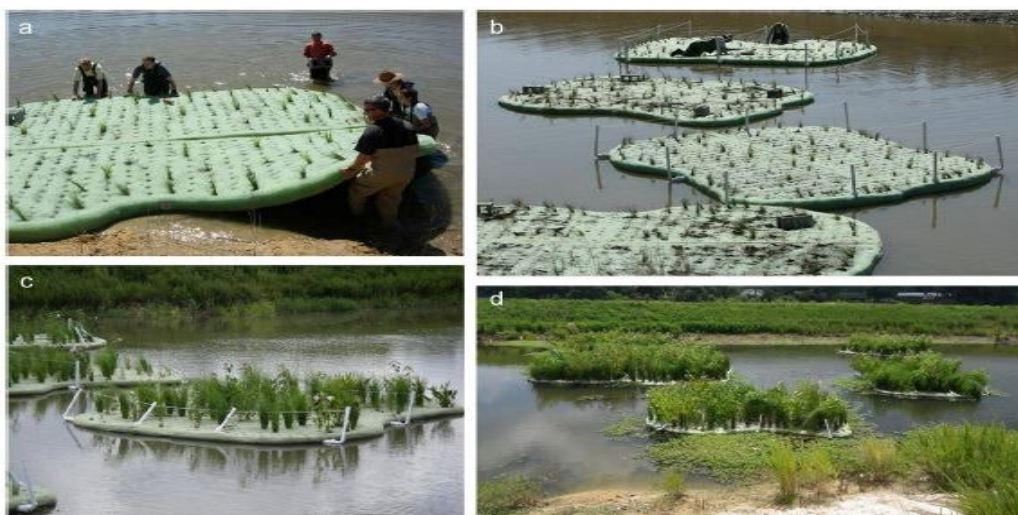
Рис.1. Схема организации плавающих биолато и пример их использования на практике
