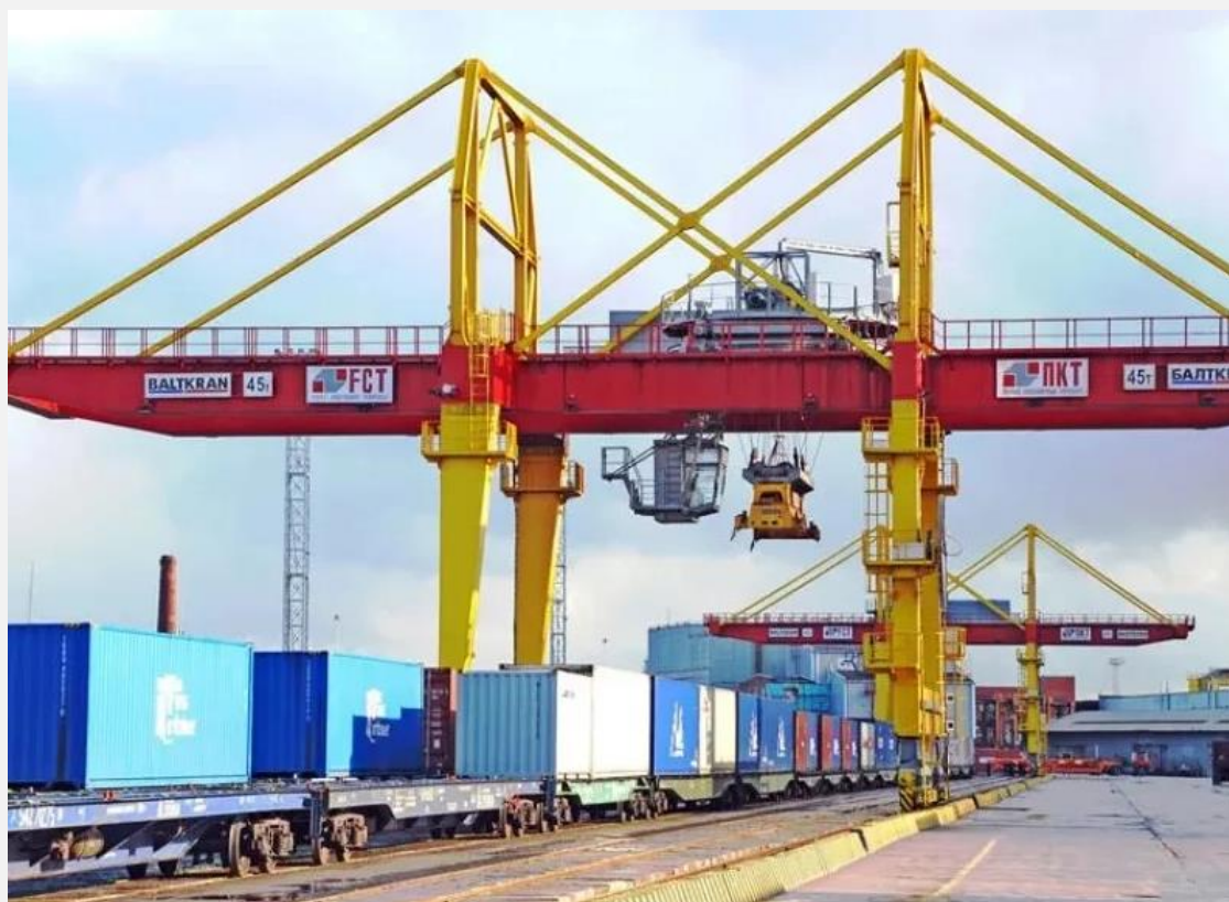
Рисунок 9.2 – Выгрузка контейнеров из железнодорожного подвижного состава козловым краном
