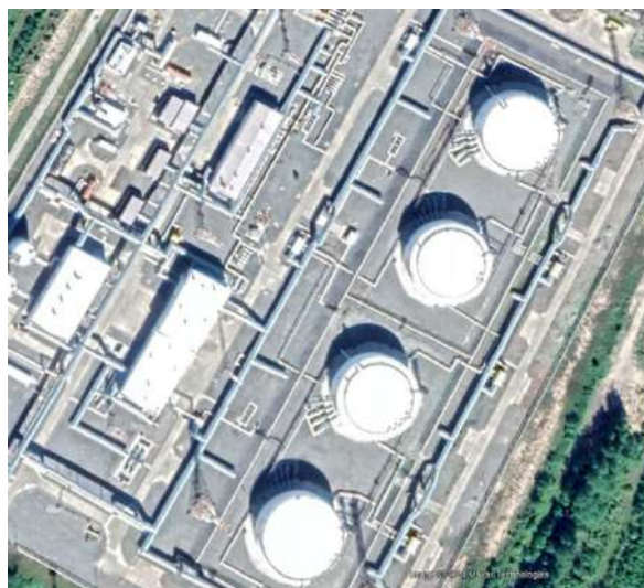
Рис. 3. Резервуарный парк и технологические здания
