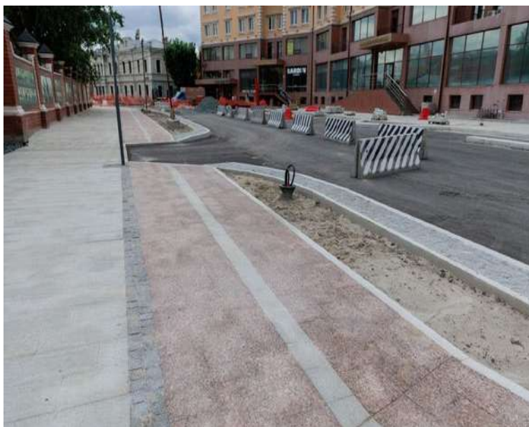
Рис. 3. Реконструкция ул. Ленина
