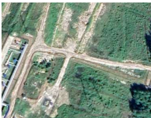
Рис. 6. Грунтовая дорога видны неровные края и неоднородность по ширине полотна
