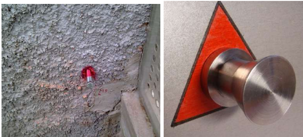
Рис. 2. Осадочная марка
