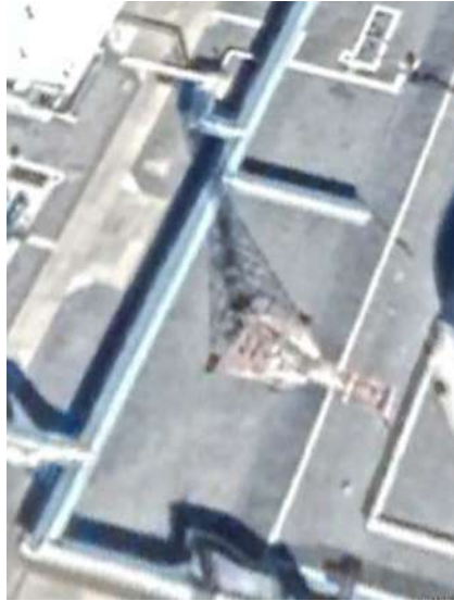
Рис.4. Точечные объекты - стальная опора линий электропередач
