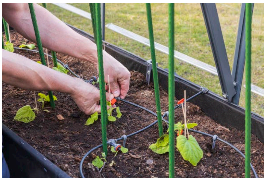
Рисунок 3 – Монтаж автоматического полива в теплице
