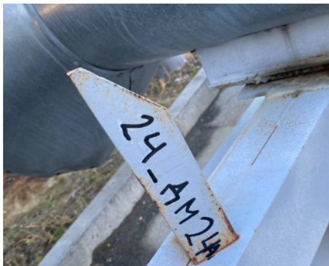
Рис. 4. Деформационная марка
